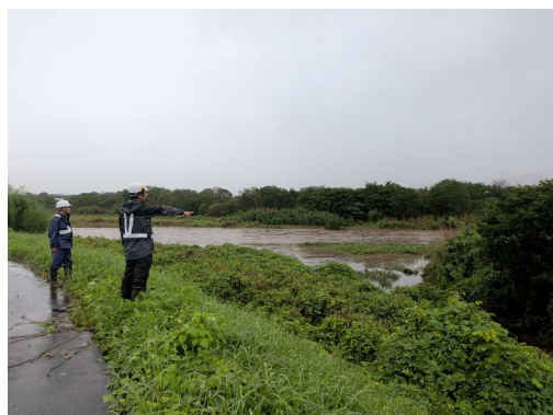
鈴鹿川水系 安楽川 左岸2.0kp 付近
