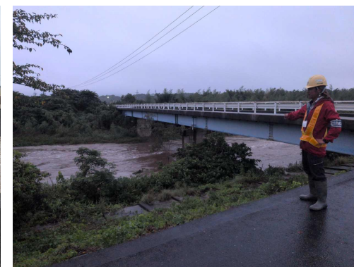
雲出川水系 中村川 右岸1.4kp 付近
