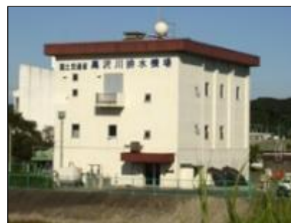
黒沢川排水機場
