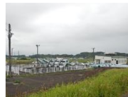
江川救急内水排水機場
