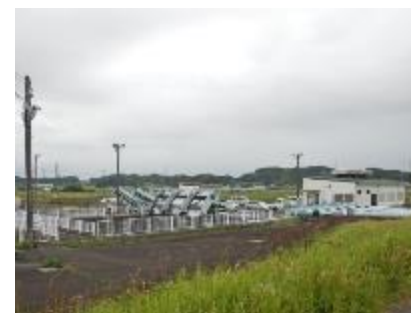
江川救急内水排水機場
