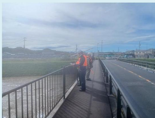
菊川 加茂水位観測所付近
