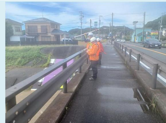
牛淵川 横地水位観測所付近
