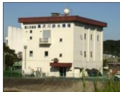
黒沢川排水機場
