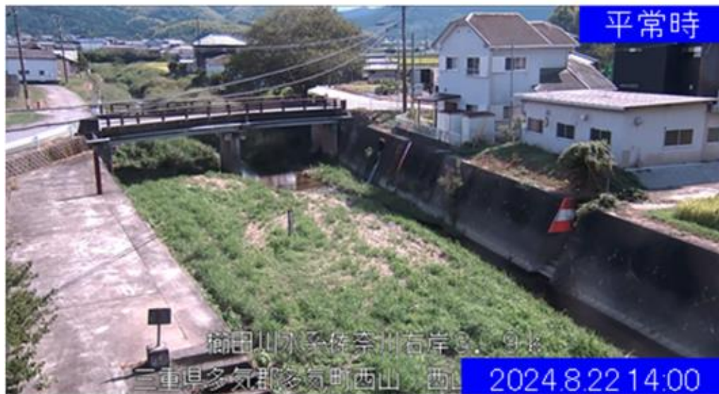
西山橋水位観測所 平常時の状況
