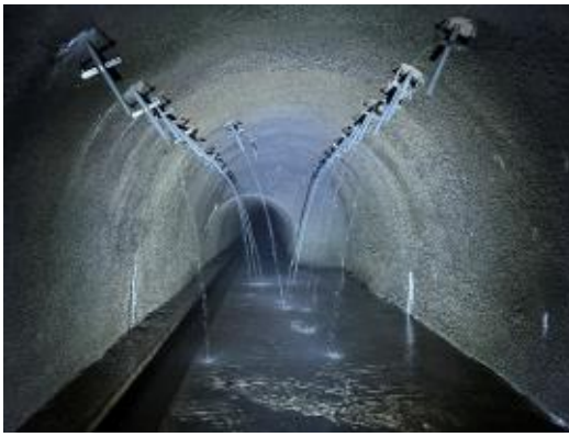
排水トンネルの排水状況
