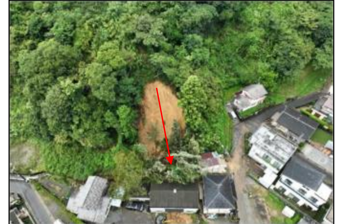
①がけ崩れ(静岡県 静岡市葵区内牧) うちまき
