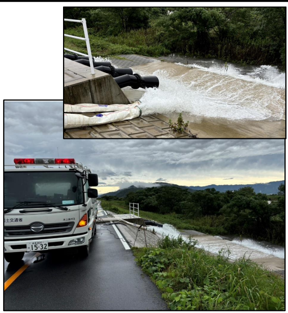
排水ポンプ車稼働状況 (岐阜県養老町)
