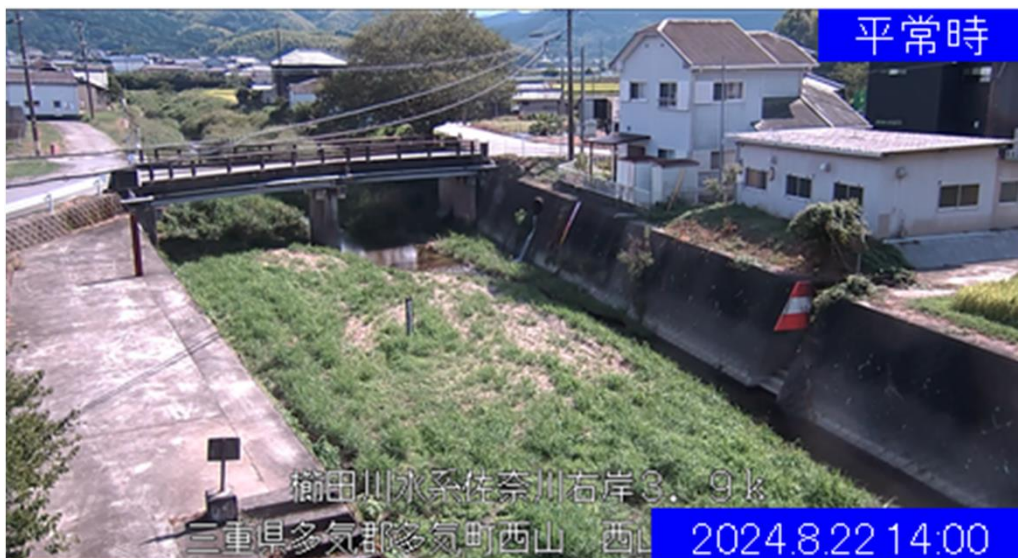
西山橋水位観測所 平常時の状況
