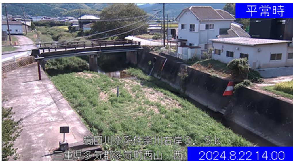
西山橋水位観測所 平常時の状況
