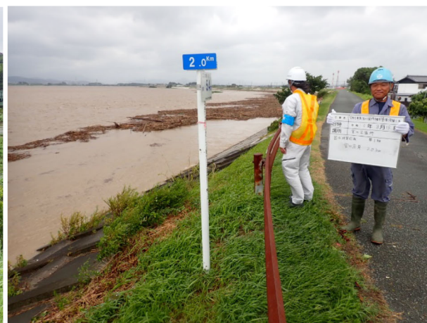
宮川左岸2.0k 付近
