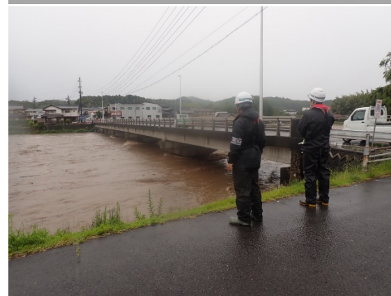
河川巡視 橋脚状況の確認
