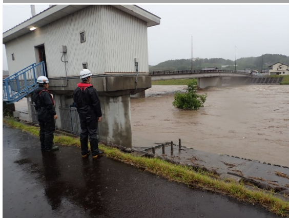
河川巡視 施設状況の確認
