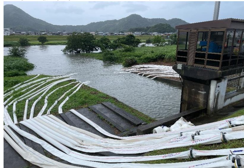
○境川排水機場排水ポンプ車活動状況2
