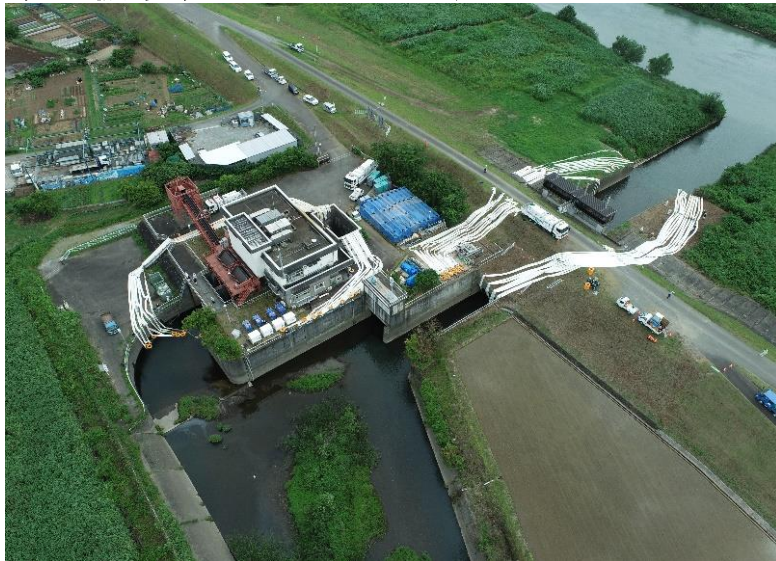
○境川排水機場排水ポンプ車活動状況
