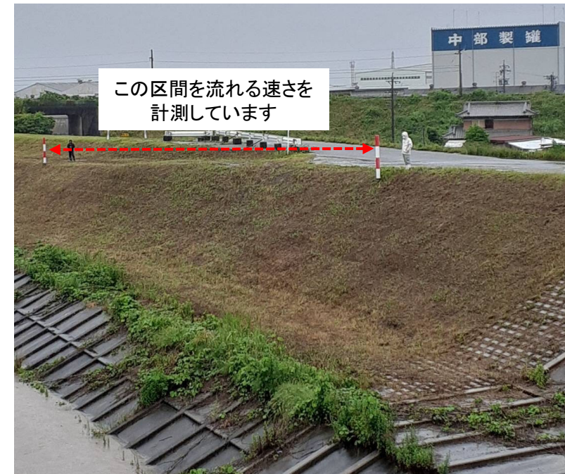
流れる速さを計測する区間
