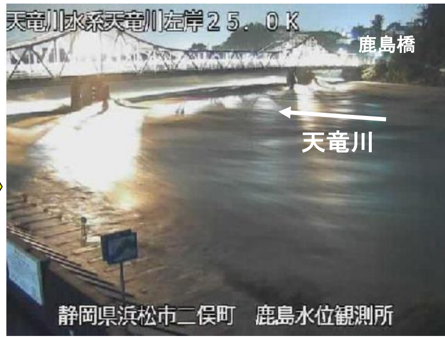
天竜川 鹿島観測所の状況(6月2日 24:00)
