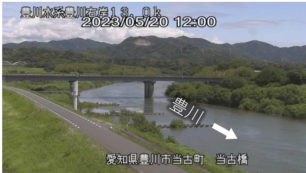
当古水位観測所 平常時の状況
