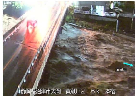
黄瀬川の出水状況 6/2 21:50頃 2.6k付近
