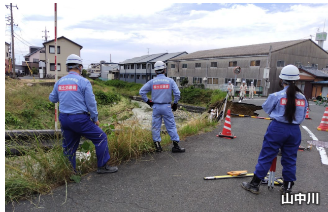
山中川 ②復旧資材の提供 (袋詰め玉石112個 6/5 豊橋より提供)
