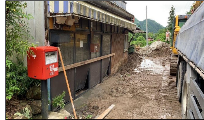
①土石流等(長野県 飯田南信濃南和田)
