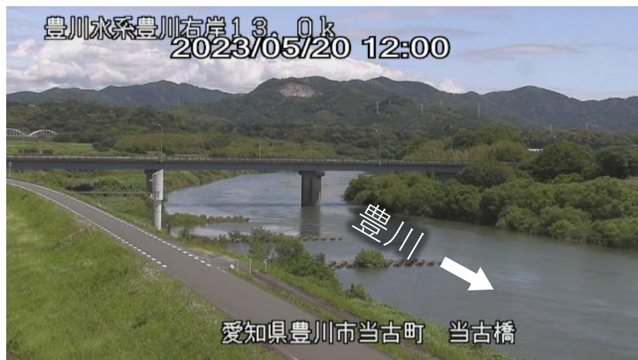
当古水位観測所 平常時の状況
