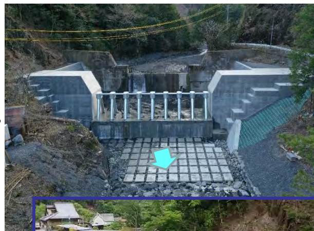
流木捕捉工設置後（H30撮影）
