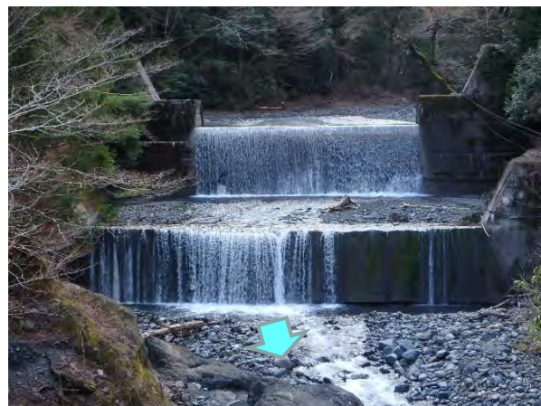
流木捕捉工設置前（H27撮影）
