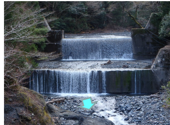
流木捕捉工設置前 (H27撮影)
