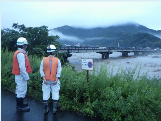
藁科川 牧ヶ谷橋上流付近
