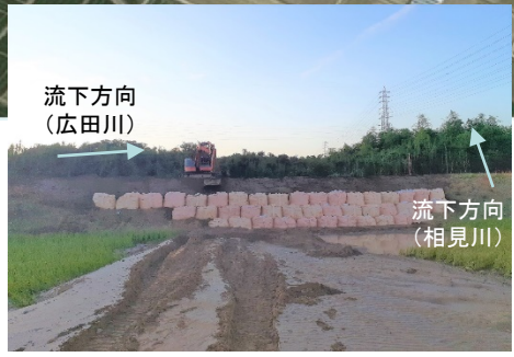
写真② 応急対策完了 9/25 17:50
