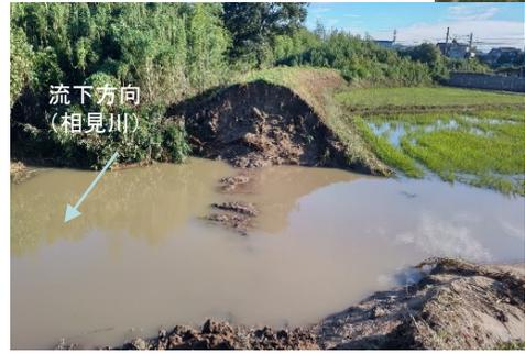
写真① 破堤箇所(近景) 9/24 7:30
