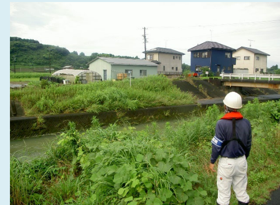
牛淵川 三沢橋付近
