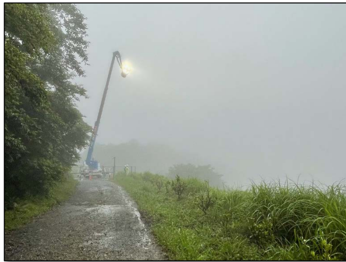
照明車稼働状況(熱海市)
