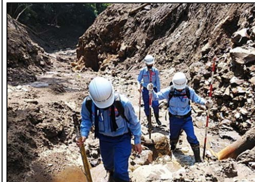
土砂流出状況を調査
