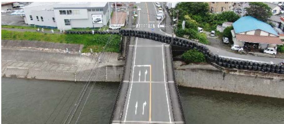
ドローンによる調査 (静岡県沼津市)
