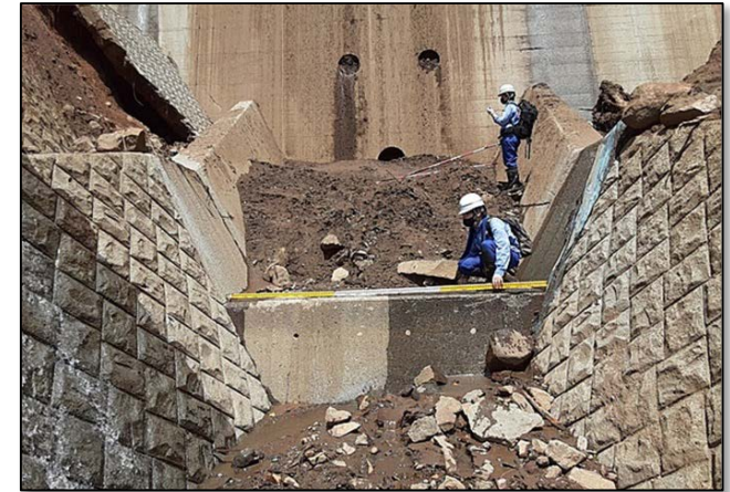
既設砂防えん堤にて土砂流出状況を調査
