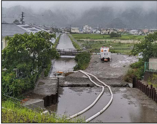
市による排水作業 (静岡県沼津市)
