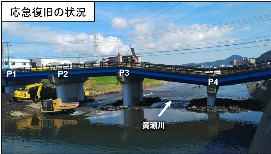
P4橋脚周辺捨石工（令和3年7月20日（火）撮影）
