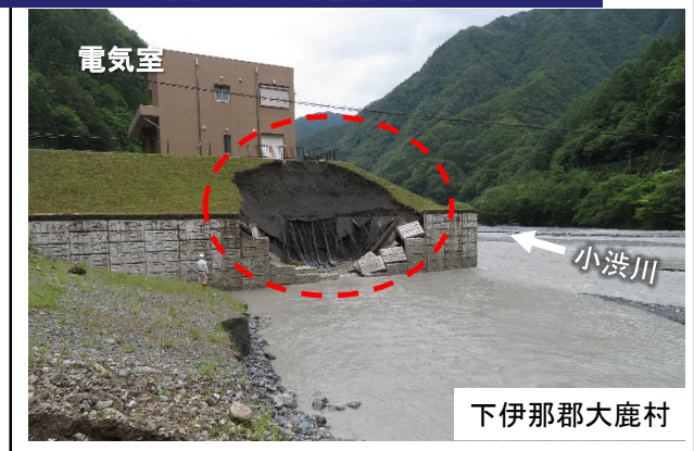
③小渋ダム土砂バイパストンネル呑口下流における被災状況
