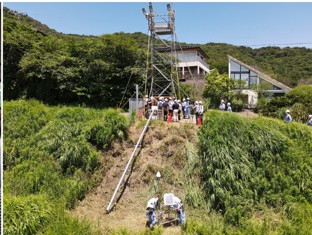
逢初川源頭部におけるGPS観測装置の設置状況
