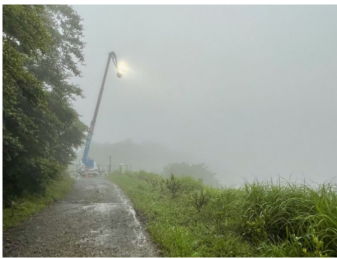
照明車稼働状況(熱海市)
