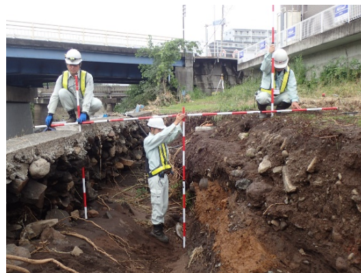
測量業者による現地調査 (静岡県駿東郡長泉町)
