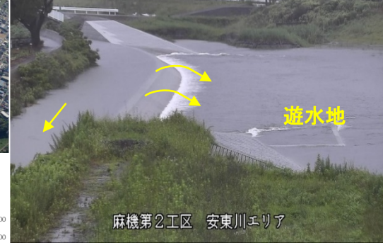
遊水地(第2工区)への越流状況(令和3年7月3日)
