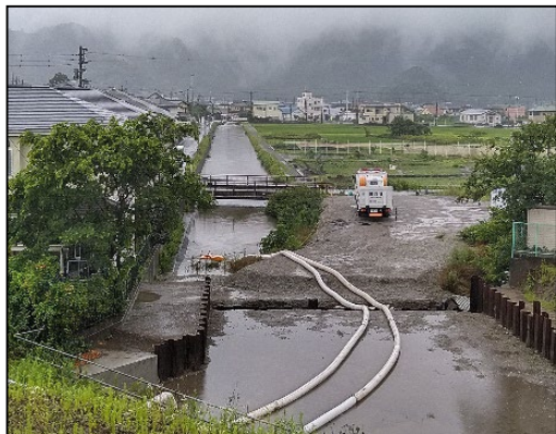
市による排水作業 (静岡県沼津市)
