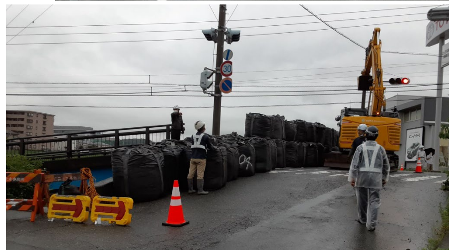
建設業者による大型土のう積み (静岡県沼津市)
