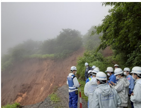
被害状況調査(熱海市)
