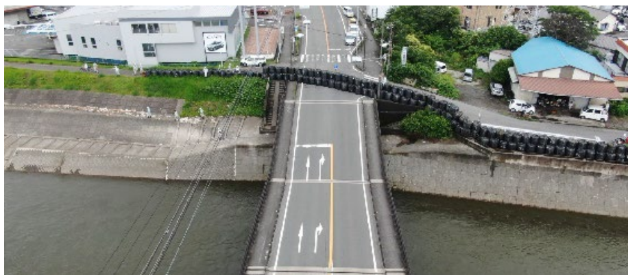
ドローンによる調査 (静岡県沼津市)
