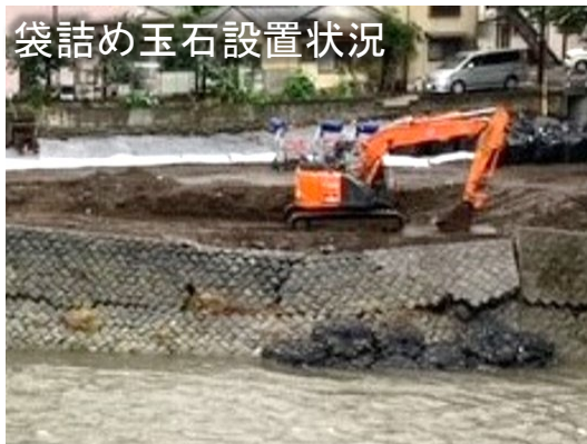
応急復旧の状況
