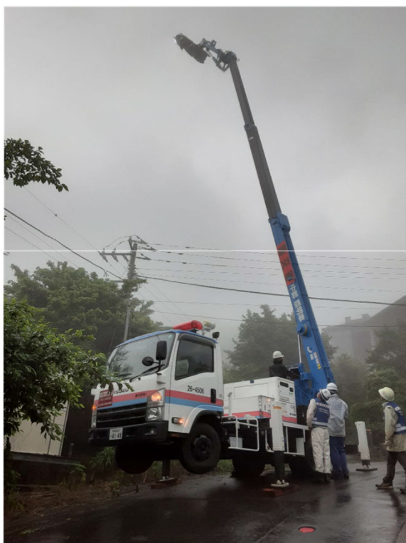
照明車現地活動状況
