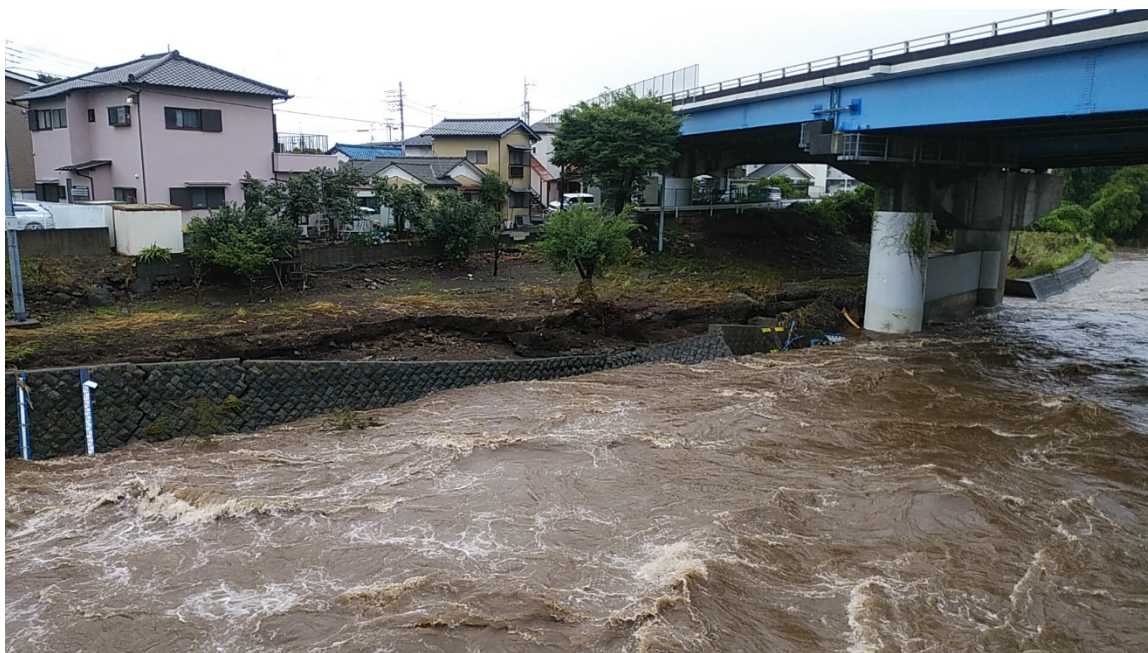
損壊した黄瀬川本宿の護岸
