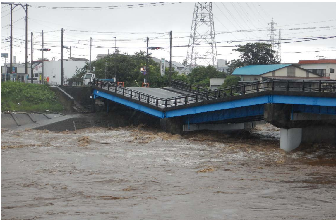
黄瀬川大橋橋脚、橋梁の損傷
