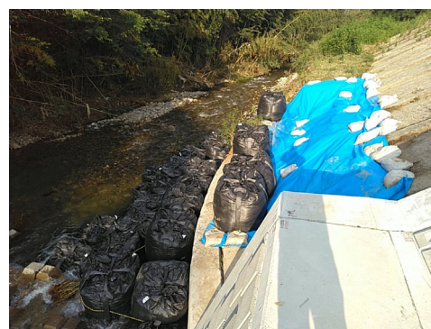
R3.8.25 16:30 応急復旧 完了
