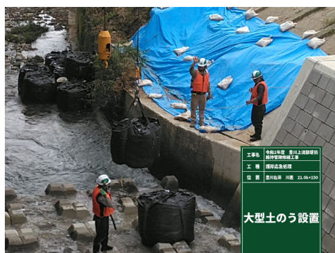
基礎部 大型土のう設置状況
