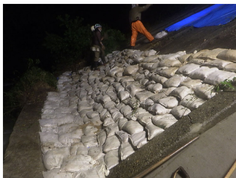
法枠護岸部 土のう設置状況
