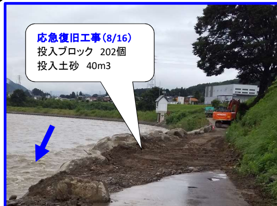
8月16日17:00 応急復旧工事完了(欠損箇所)
