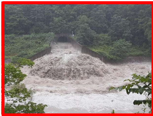
土砂バイパストンネル吐口（8月15日8時頃） 土砂バイパス放流量 約200 m^3/s
