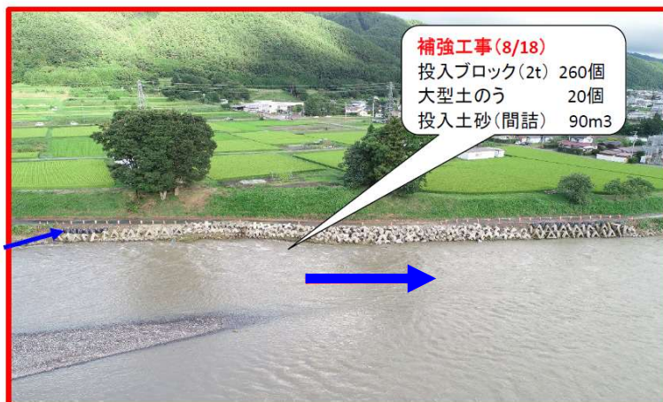
8月18日17:00 補強工事完了 (欠損箇所の上下流を補強)
