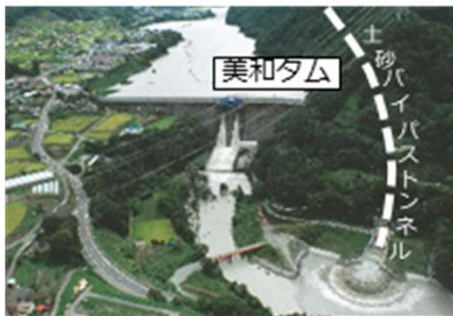
土砂バイパストンネル吐口
