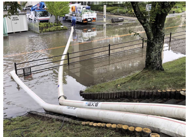
排水ポンプ車の稼働状況
