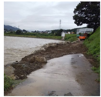
応急復旧完了
