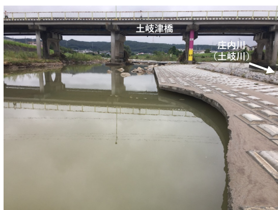
土岐津橋下流（被災後）
