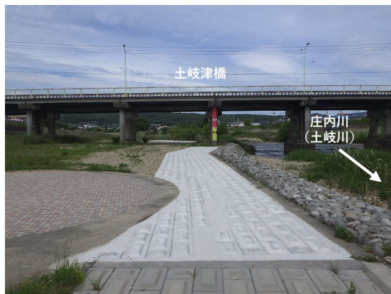
土岐津橋下流（被災前）
