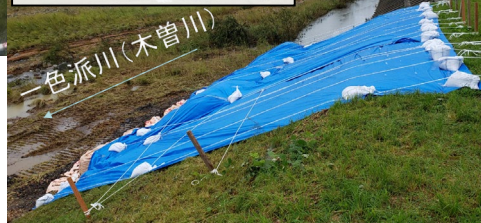
応急復旧完了 (8月17日16時頃)
