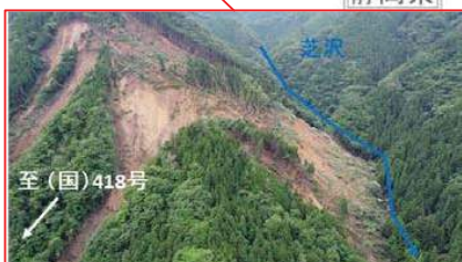
●天龍村足瀬 (土砂崩落)
