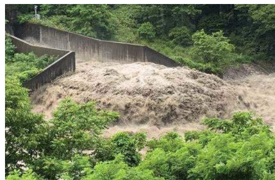
土砂バイパストネル放流状況(7月1日7:20)
