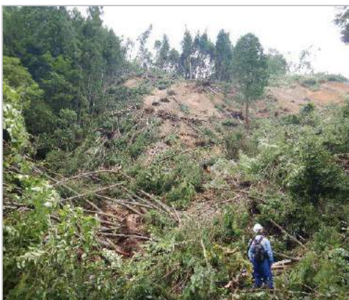
土砂崩落現場の現地調査 (天龍村足瀬)
