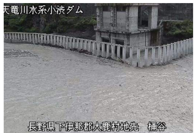
土砂バイパストンネル呑口 (7月1日 11時頃)
