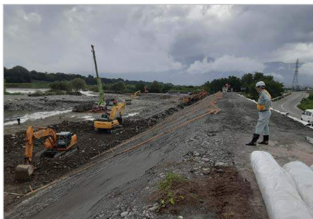
7月7日16:00【復旧工事】 堤防盛土完成
