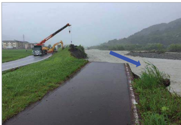
7月1日11:00【復旧工事】 欠損確認後3時間後 ブロック及び土砂の投入
