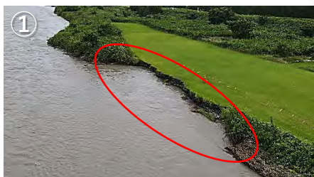
① 吉田町川尻地先(大井川右岸0.0k) 7/28 16:00頃ドローンによる現地調査
