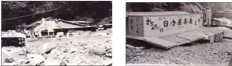
土石流により被災した梅ヶ島温泉
