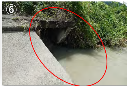
⑥ 静岡市牧ヶ谷地先(藁科川右岸0.5k) 7/28 11:30頃現地調査
