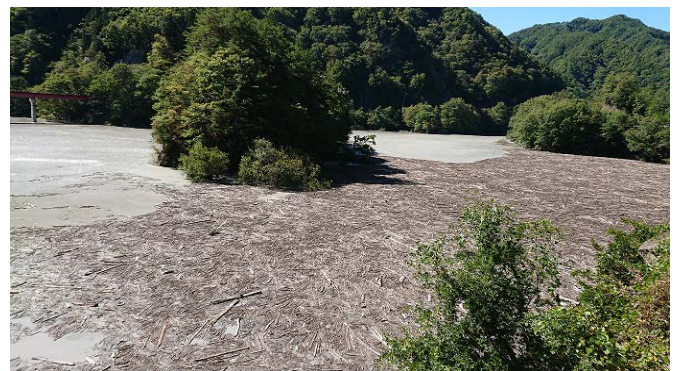
小渋ダム流木補足状況写真
