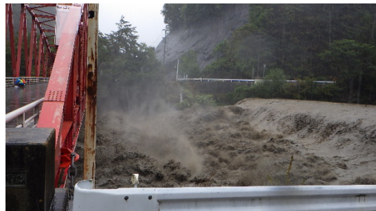
飯島堰堤（10月12日 13時頃）
