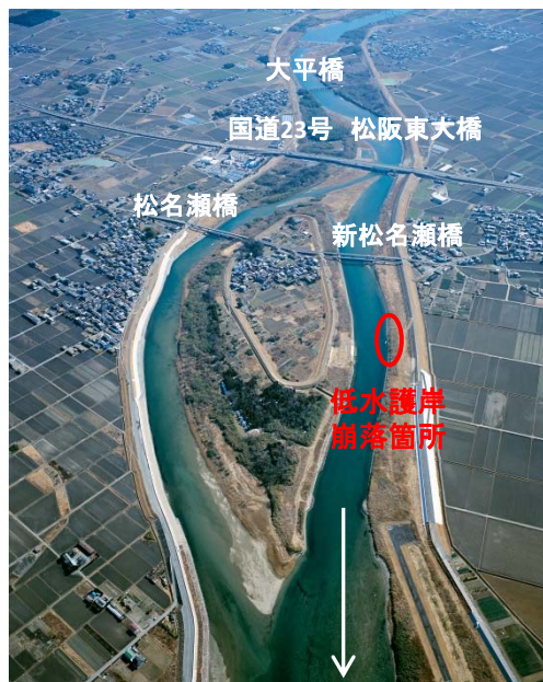
橿田川 被災箇所
