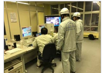
勢田川防潮水門 勢田川排水機場 操作状況
