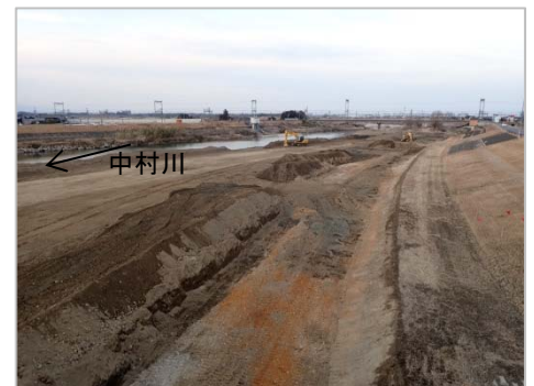
河道掘削実施状況
