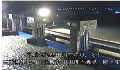
勢田川防潮水門 閉鎖中 勢田川排水機場 排水中
