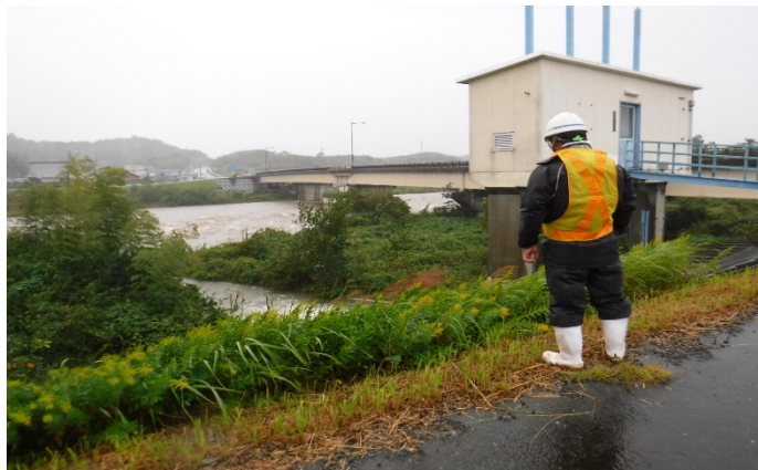
櫛田川 新両郡橋
