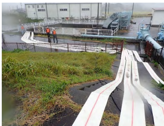
ホース接続完了(江川排水機場応援)
