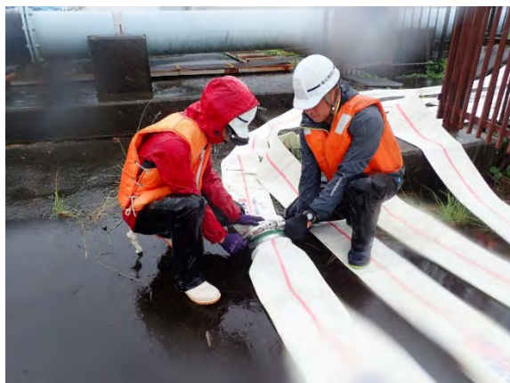
ホース接続(江川排水機場応援)
