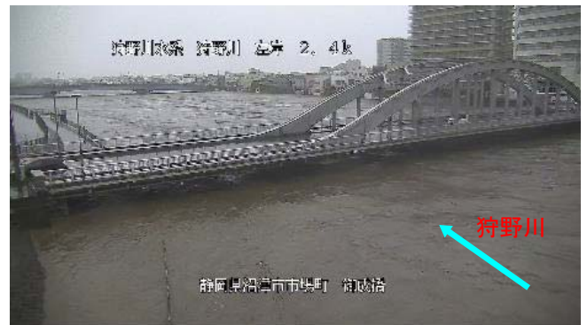
台風第19号による出水状況(10/12 15:30)
