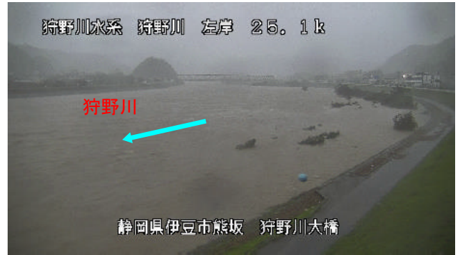
台風第19号による出水状況(10/12 16:20)
