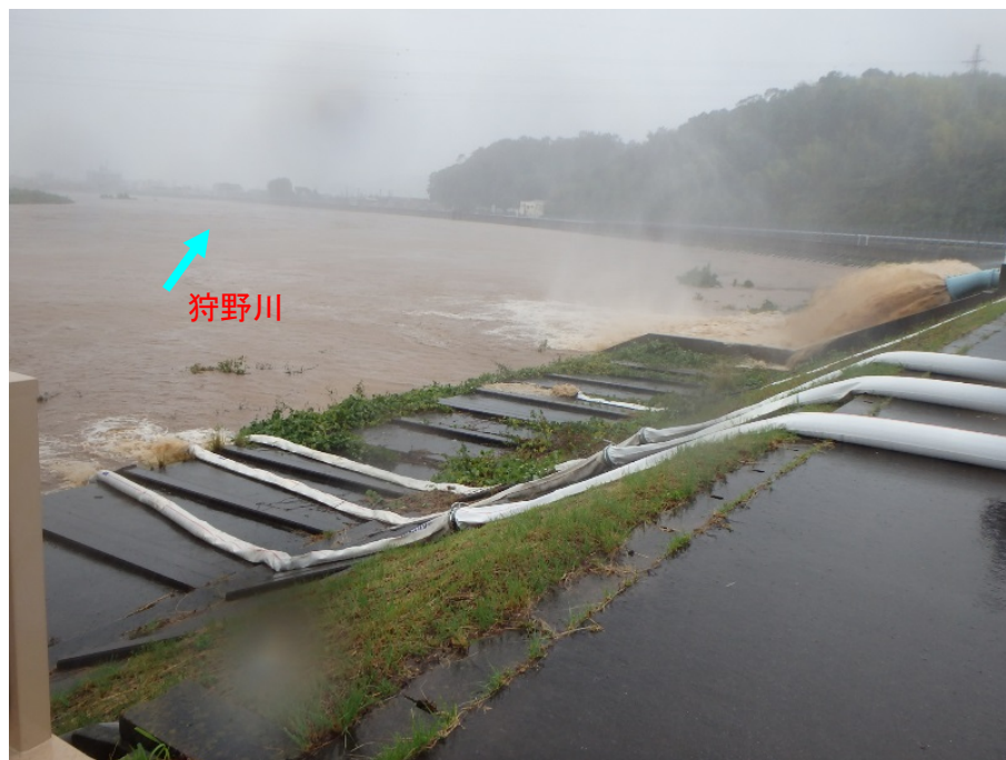
伊豆の国市宗光寺川における稼働状況
