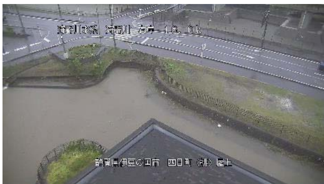
台風19号による出水状況(10/12 08:10)
