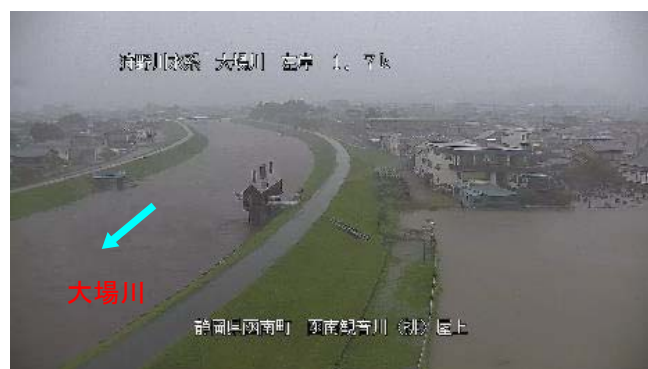
台風19号による出水状況(10/12 15:00)
