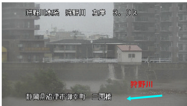
台風19号による出水状況(10/12 11:40)
