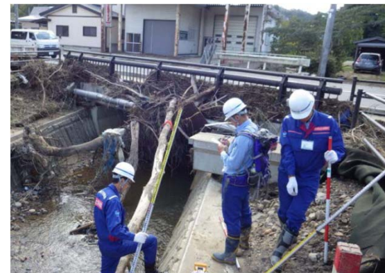
岩手県久慈市北の越川 被害状況調査
