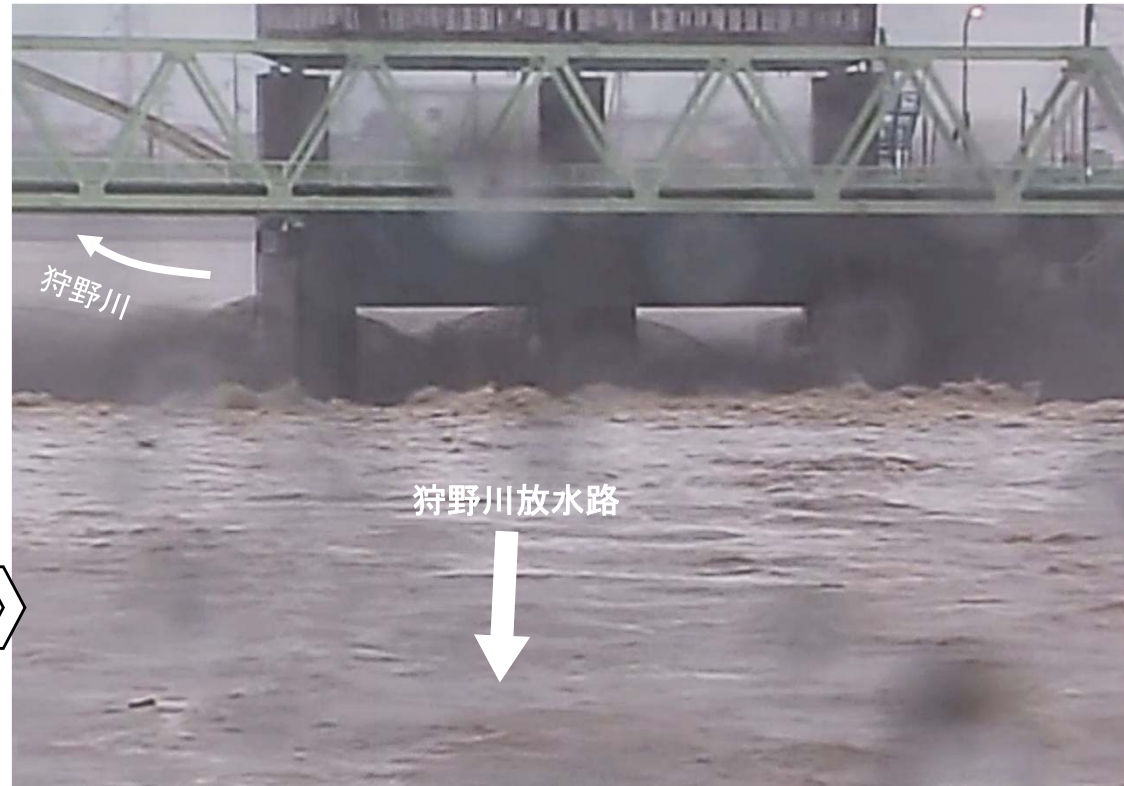
狩野川放水路が狩野川の洪水（台風第19号）を大幅に低減する様子 （昭和40年完成）
