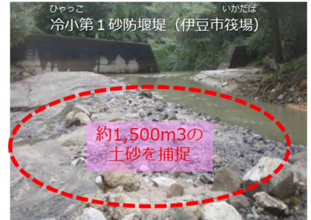
台風19号豪雨に伴う流出土砂の捕捉状況
