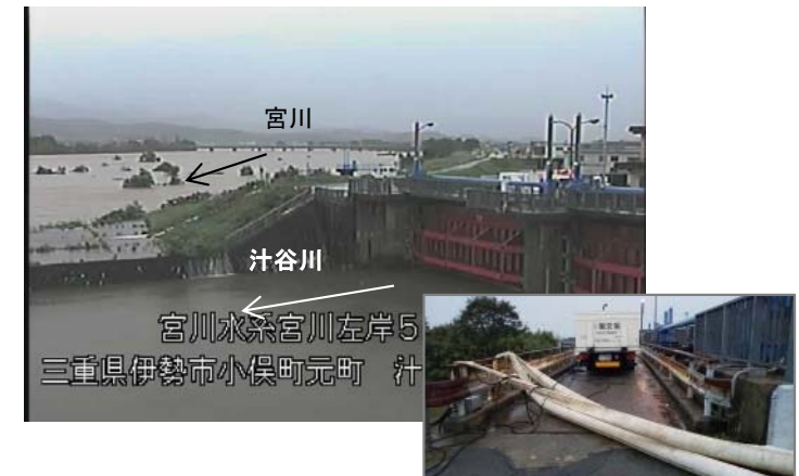
伊勢市汁谷川水門における稼働状況
