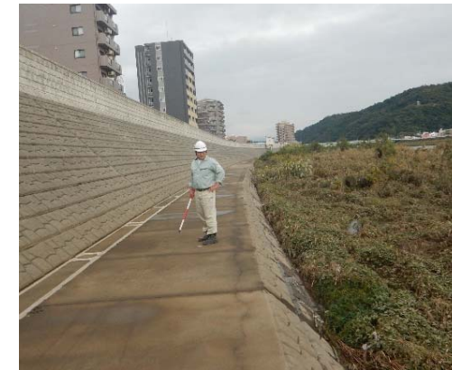
堤防や護岸の確認調査
