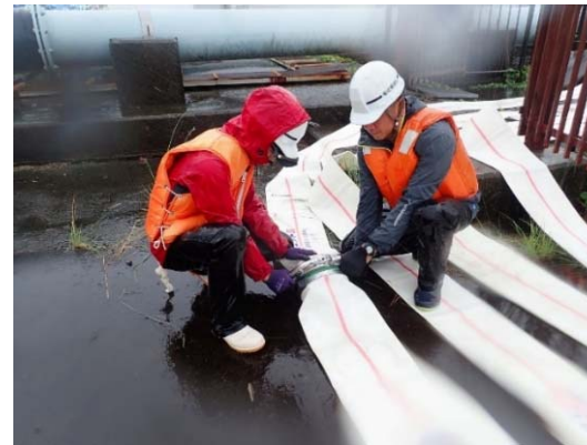
建設事業者による排水準備作業 (静岡県菊川市)
