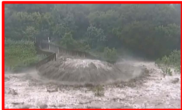
土砂バイパストンネル吐口 (10月12日 14時頃)
