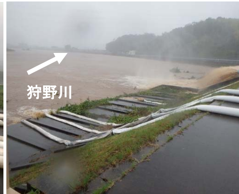
伊豆の国市宗光寺川における稼働状況
