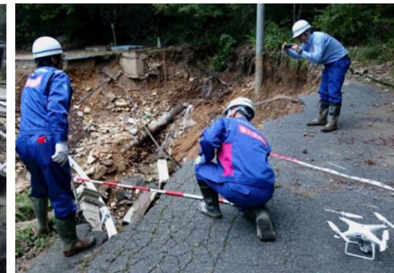
岩手県宮古市崎山付近 被害状況調査
