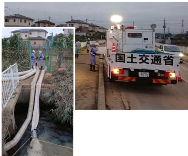
埼玉県坂戸市 排水作業
