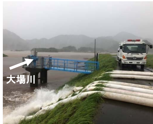
三島市御園地区における稼働状況
