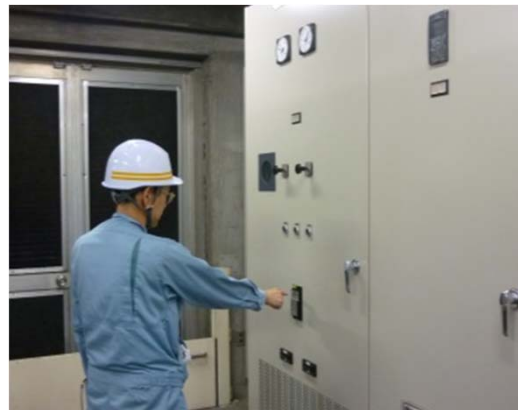
電気通信機器の監視
