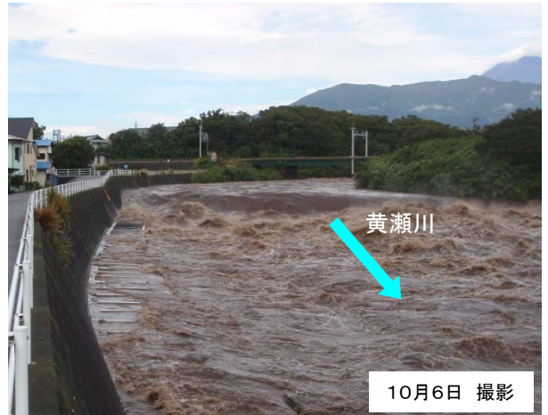
台風第18号による出水状況
