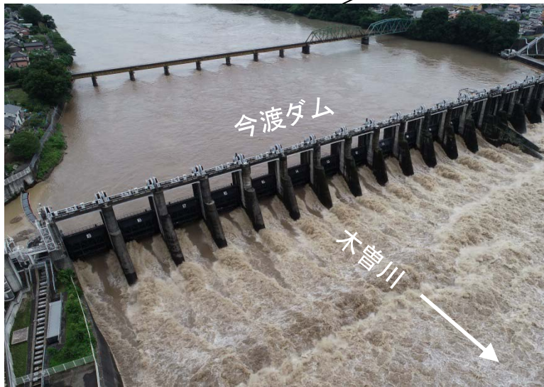
今渡ダムからの放流（7月8日11時頃） 70.4k（今渡ダム）付近
