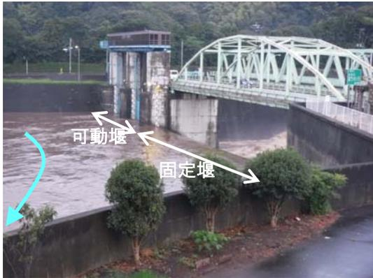
狩野川放水路固定堰を越流し、さらに水位上昇が見込まれることから、9月5日5時15分に放水路を開放。（9月5日8時20分に全閉）
