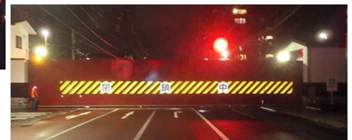
7月8日午前0時30分頃 長良陸閘の閉鎖状況 15
