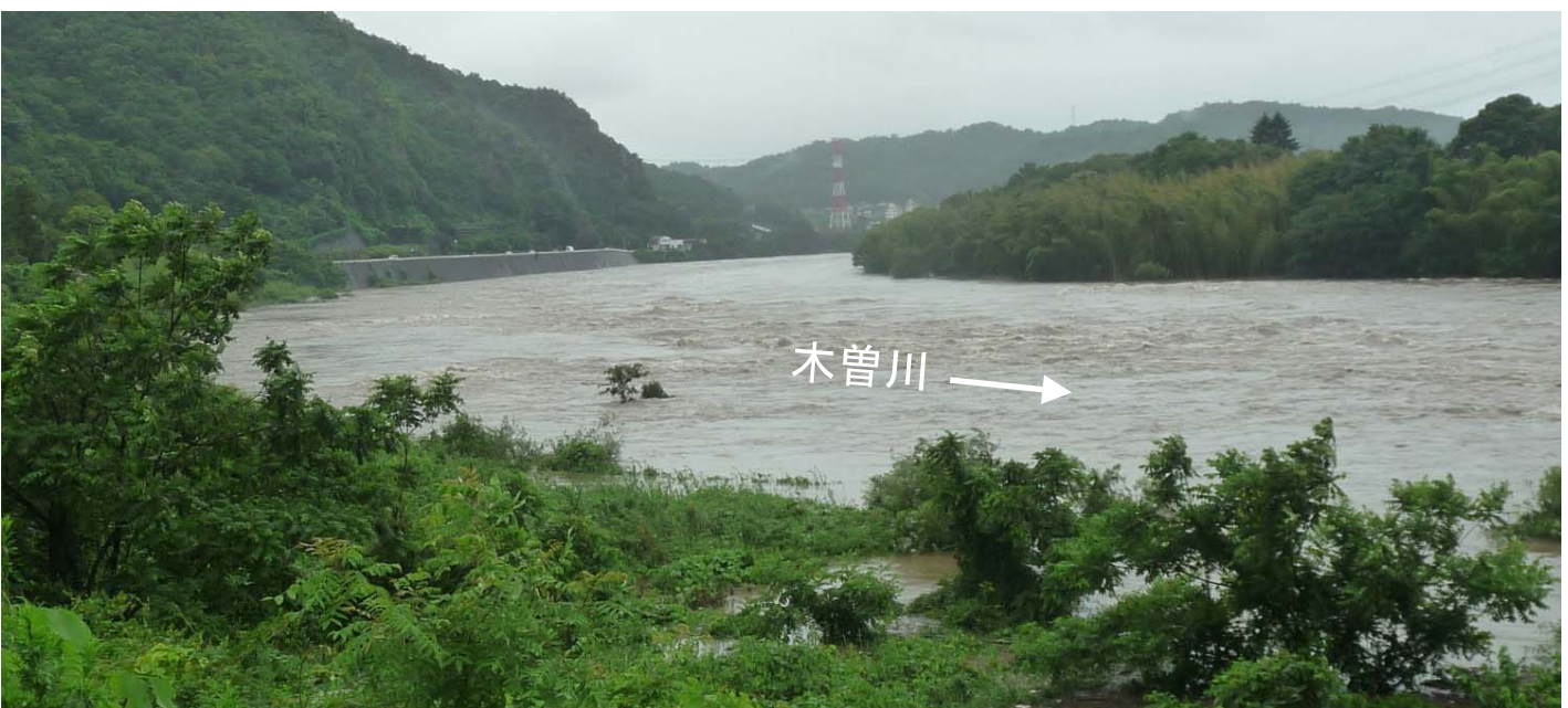
木曾川の出水状況 (7月5日14時頃) 61.2k付近
