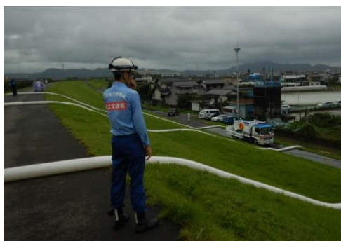
7月7日照明車及び排水ポンプ車稼働状況
