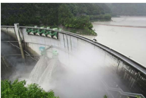
防災操作状況(7月6日15:30)
