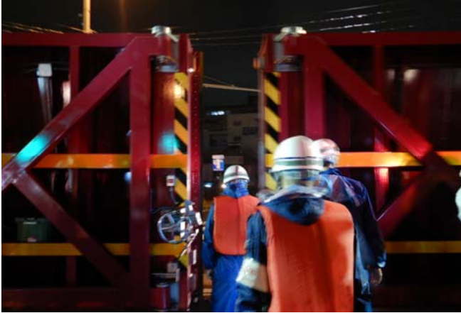
大宮陸閘の閉鎖状況(7月8日0時30分頃)
