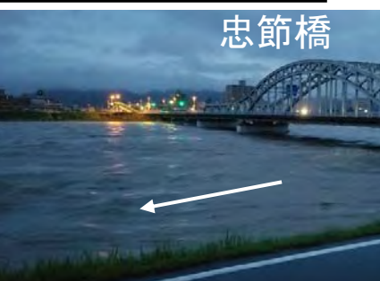
写真②忠節橋地点付近
