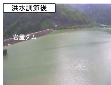
洪水時最高水位に近づく貯水池の状況 (7月8日 15時30分頃)
