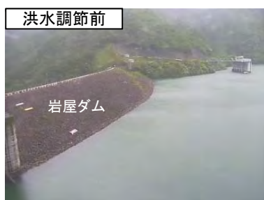
洪水貯留開始前の貯水池の状況 (7月4日9時頃)
