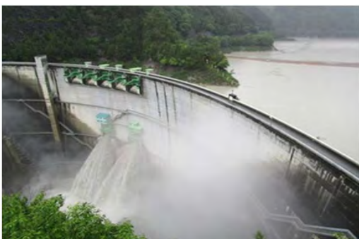
防災操作状況(7月6日15:30)
