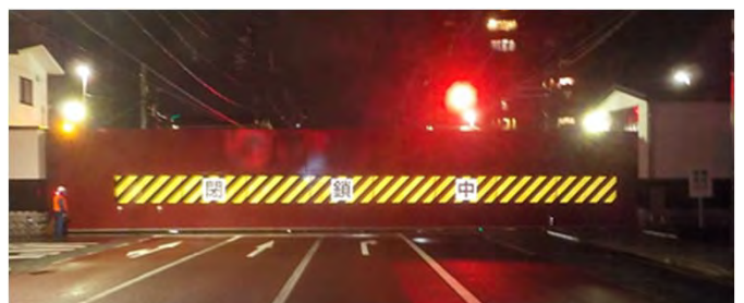
7月8日午前0時30分頃 長良陸閘の閉鎖状況 10
