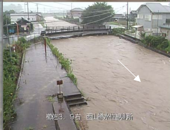
櫛田川支川 佐奈川 西山橋(3.9k右岸) 9日16:20 多気郡多気町西山地先
