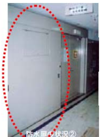
防水扉の状況②
