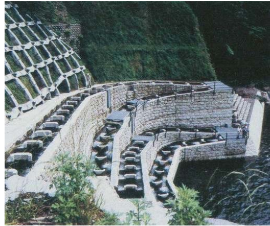
形式：アイスハーバー改良型階段式魚道 倉見砂防堰堤魚道
