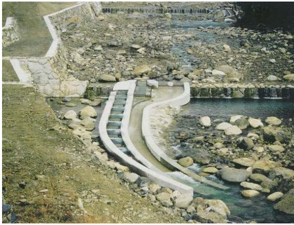
形式：階段式魚道（呼び水水路付き） 湯舟沢床固工魚道
