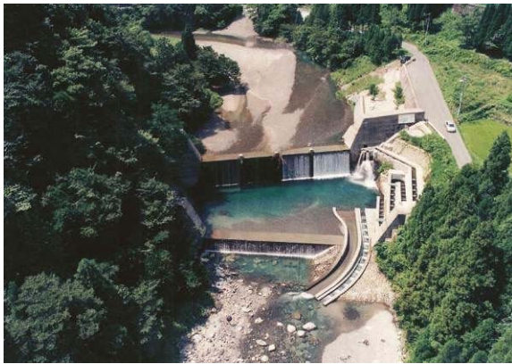
本堤：階段式魚道 副堰堤：階段式魚道（呼び水水路付き） 坂内砂防堰堤 魚道
