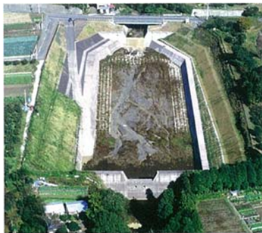
沈砂地工
