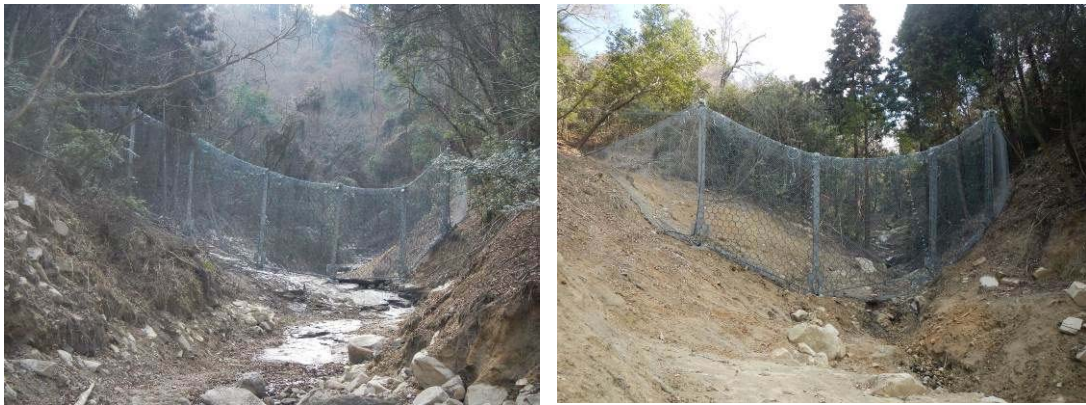
写真 16-2-1 強靱ワイヤーネット工(事例)
