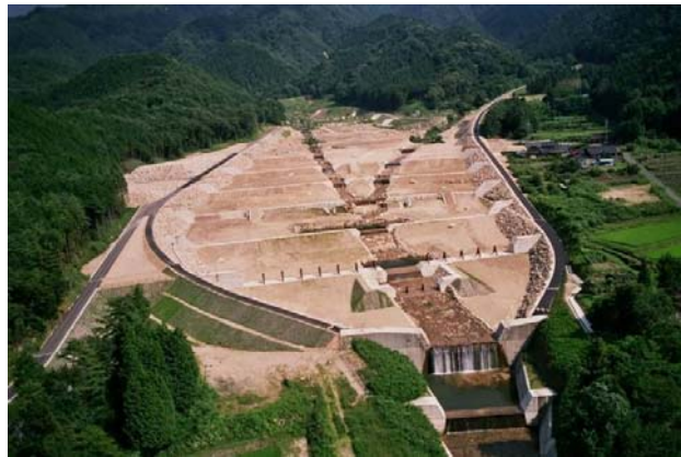
図 6-3-2 遊砂地の構造物のレイアウト
