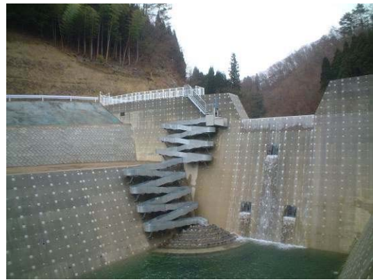
形式：たて型壁面魚道 山の谷第一砂防堰堤
