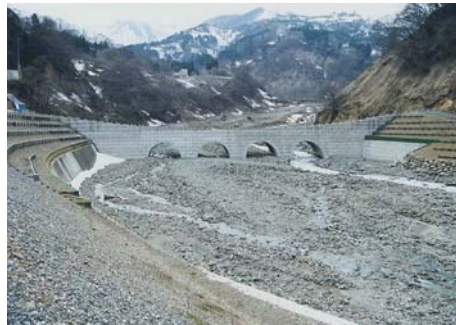
事例：浦川スーパー暗渠砂防堰堤 (国土交通省 北陸地方整備局 松本砂防事務所)
