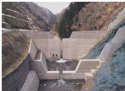
事例：根尾川ヌクミ谷 コンクリートスリット堰堤（土砂調節）
