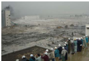
津波により被災する南國生浄化センター（宮城県仙台市）
