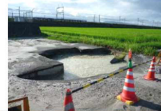
漏水による周辺陥没状況
