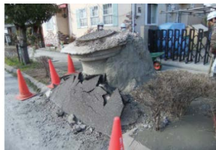
液状化により破砕したマンホール（千葉県袖台市）
