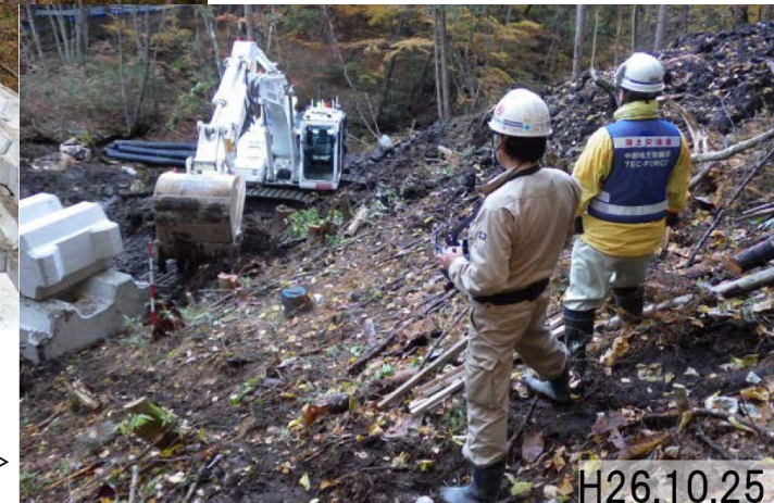
＜作業の安全性を考慮して、遠隔操作無人化施工のバックホウを採用＞
