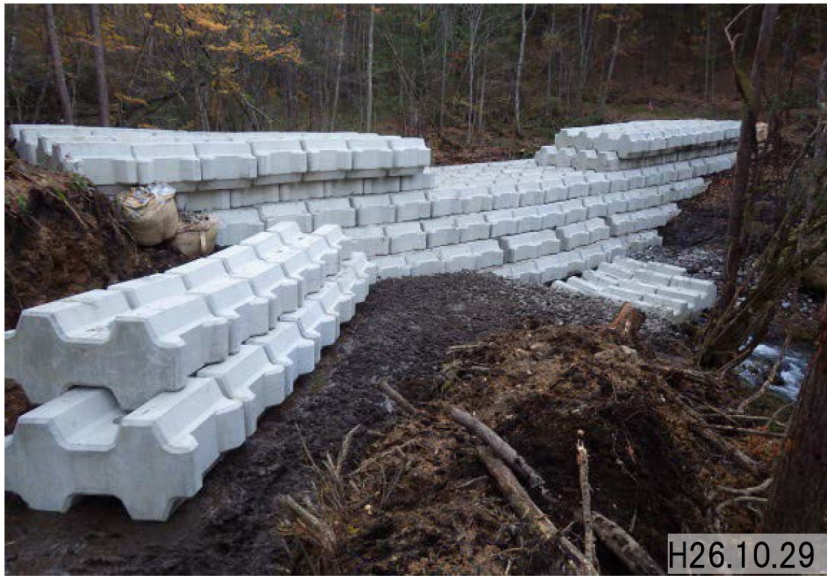
＜コンクリートブロック積み砂防堰堤＞
