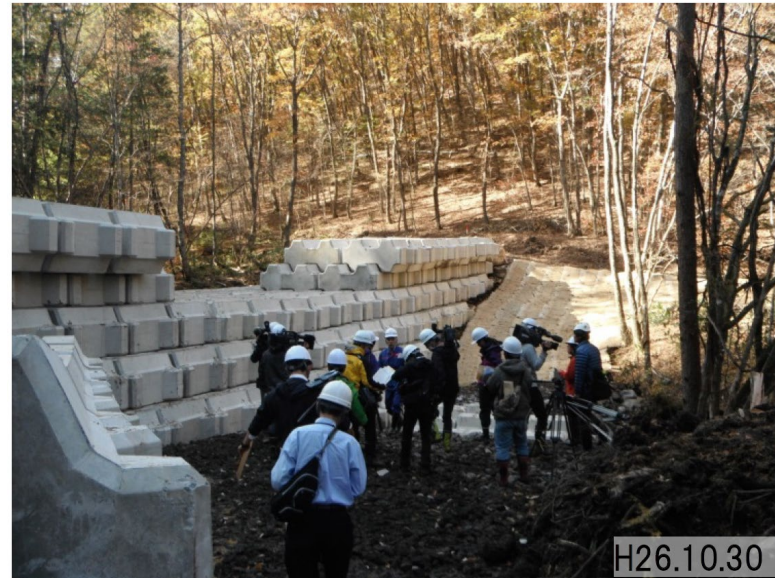
＜コンクリートブロック積み砂防堰堤完成の現地説明会＞
