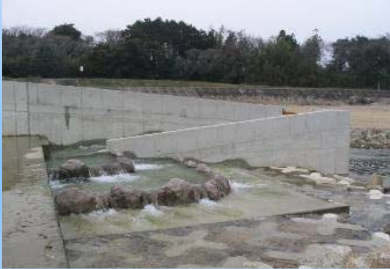
鈴鹿川本流 井尻頭首工魚道2005年3月
