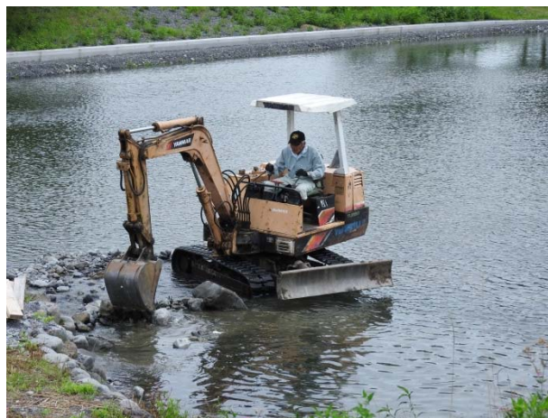
不陸整正等の施設維持整備
