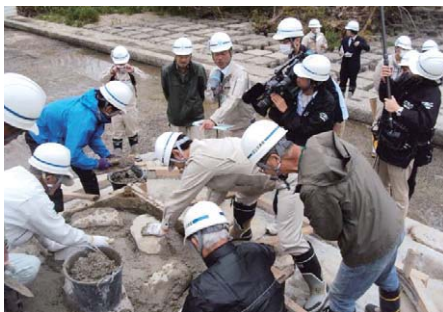
棚田魚道の施工状況 (H26.4.22)
